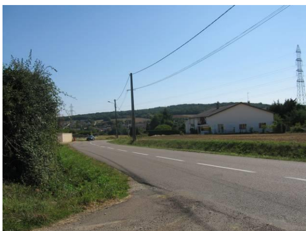
RD124 - traversée de Montreuche
