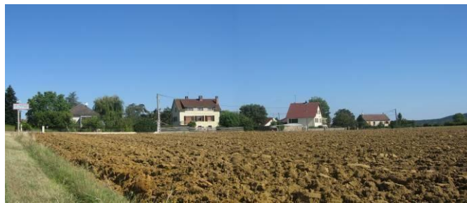
Façade urbaine sud des Chapelles
