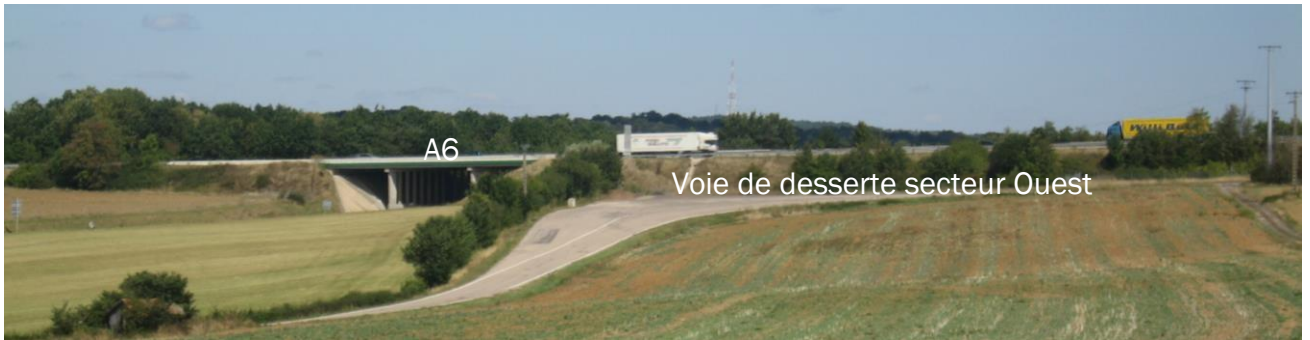
Vue vers la voie de desserte et l'A6 (secteur Ouest)
