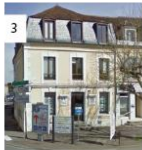
Localisation : avenue Gambetta
