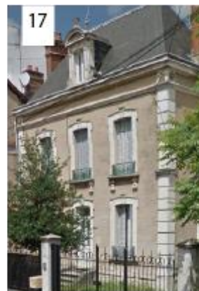
Localisation : avenue Gambetta
