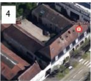
Localisation : avenue Gambetta
