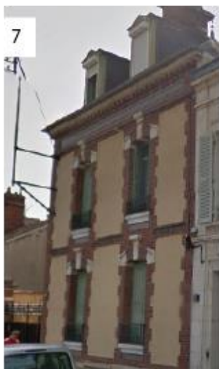
Localisation : avenue de la Puisaye
