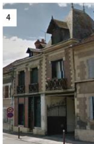
Localisation : rue du Bourneuil
