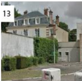
Localisation : boulevard Vauban Descriptif : Syndicat Départemental d'Énergies de l'Yonne.
