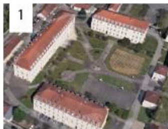
Localisation : 23 rue Faidherbe Descriptif : zone composée de 3 bâtiments répertoriés comme éléments de patrimoine.
