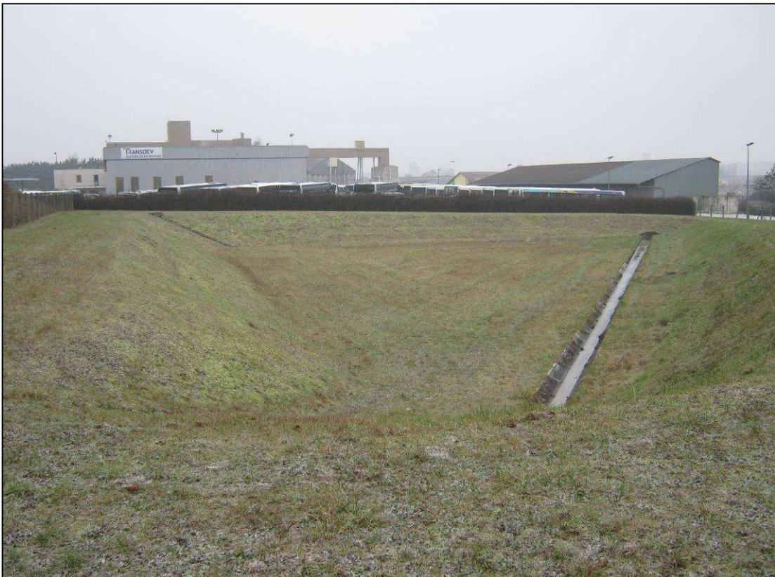
**Figure 3-11 : Compartiment est du bassin unitaire de stockage/restitution de la Chaînette avant réalisation de la dalle de couverture (4000 m<sup>3</sup>)**
