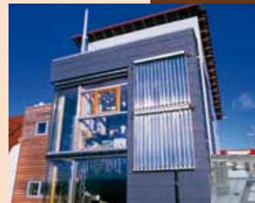
> Capteurs sous vide en façade
