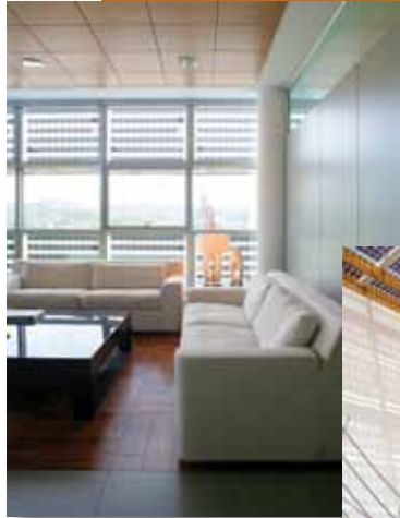
> Intégration photovoltaïque en façade vitrée
