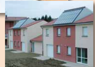
> Couverture totale en capteurs solaires thermiques (Chauffage)
