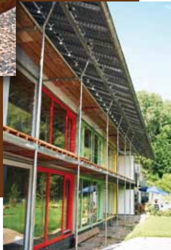
> Photovoltaïque en toiture avec auvent
