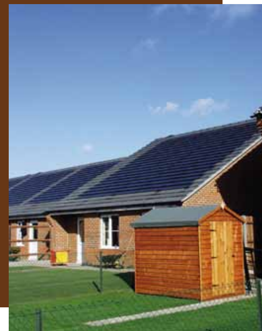
> Intégration photovoltaïque en toiture
