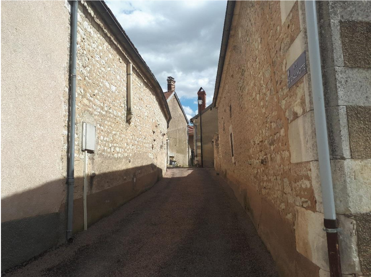
Figure 62 : photo de bâtiments en meulière (source : CDHU)
