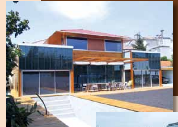
> Capteurs thermiques en façade (Chauffage)
