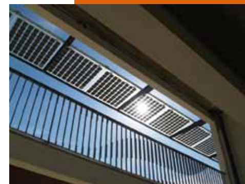
> Capteurs photovoltaïques en brise-soleil
