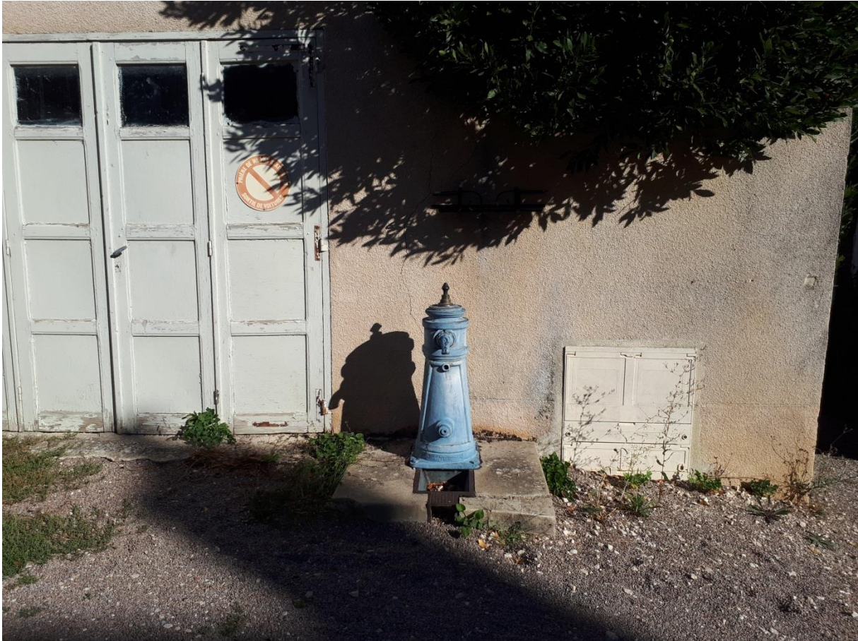
Figure 83 : Exemple de pompe à eau protégée au titre de l'article L151-19
