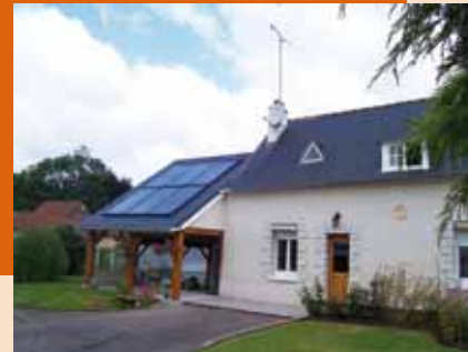
> Capteurs thermiques intégrés en toiture secondaire (Chauffage)
