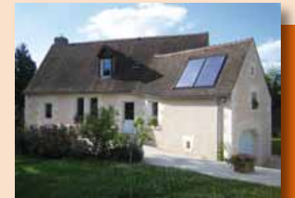
> Capteurs intégrés en toiture (CESI)
