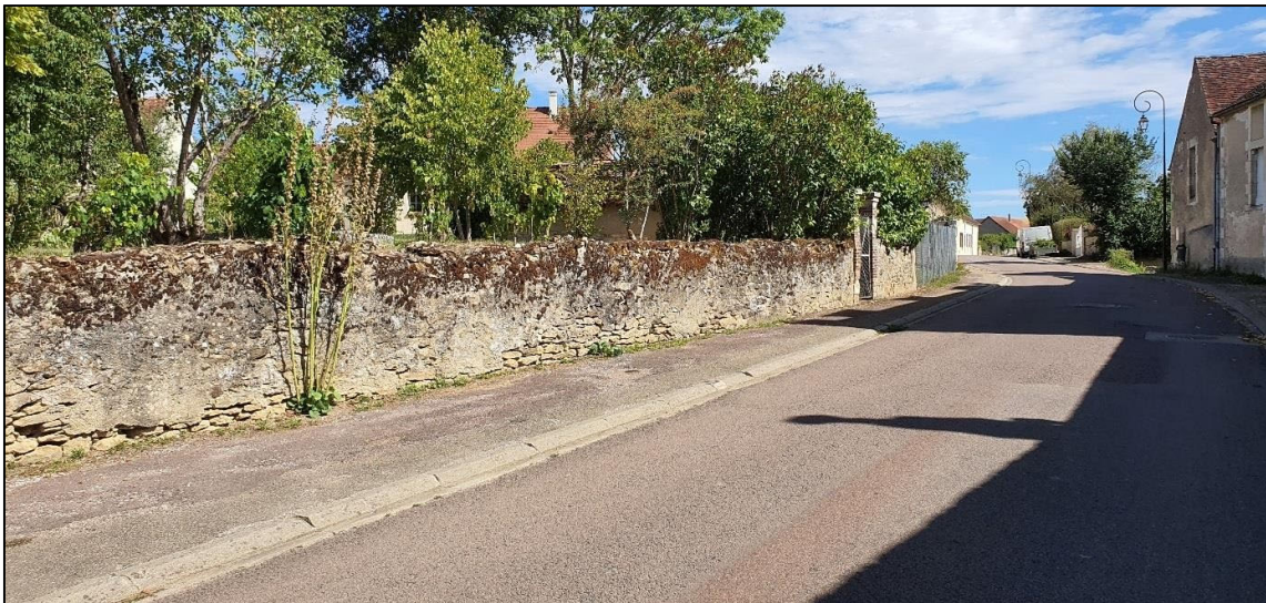
Figure 112 : Exemple de mur protégé au titre de l'article L151-19 (source : CDHU)
