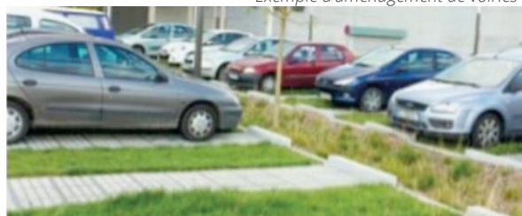
Noue végétalisée avec infiltration gravitaire du ruissellement
