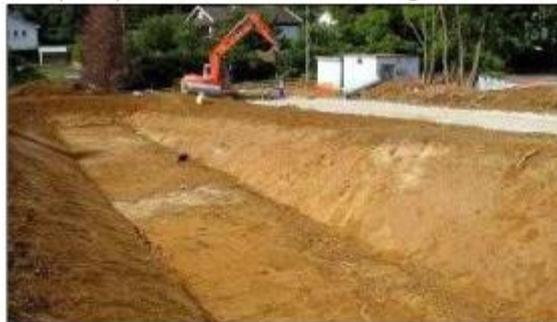
**Figure 6** : Exemple de mise en place d'un bassin de rétention des eaux pluviales
