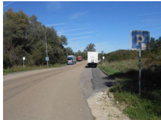
Figure 18 Parking PL à l'échangeur Auxerre Nord
