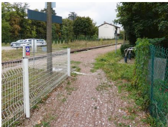
Figure 34 Quai et accès piétons à la gare de Vincelles
