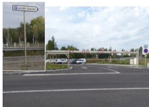
Figure 62 Nouvelle aire de covoiturage à Auxerre Nord
