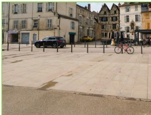
Figure 56 Traversée accessible à Auxerre
