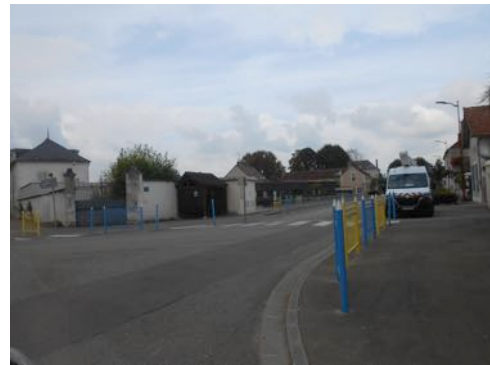
Figure 60 Sécurisation à Vincelles
