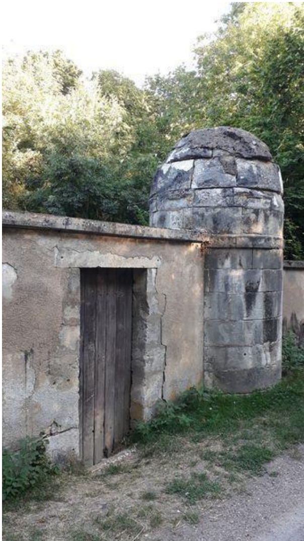
Figure 76 : petite tour à Vincelottes (photographie CDHU)
