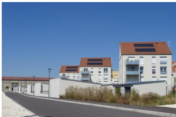
Panneaux solaires dans le résidentiel
