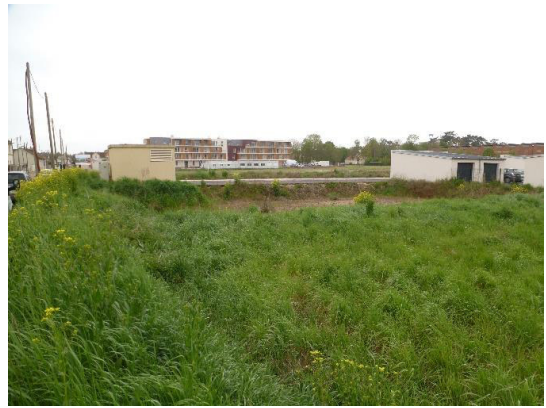
Vue sur le bassin de gestion des eaux pluviales d'intérêt écologique attenant à la rue des Montardoins
