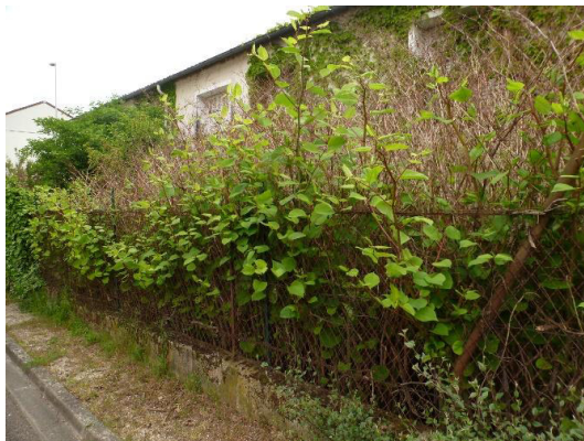
Vue sur foyer de Renouée du Japon à proximité de la rue de la Tour d'Auvergne
