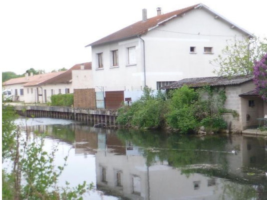
Vue sur l'aménagement anthropique des berges de l'Yonne sur l'île à restaurer
