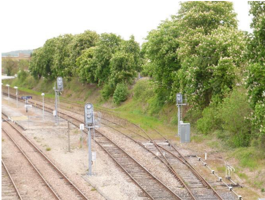
Vue sur végétation arborescente aux abords du faisceau ferré
