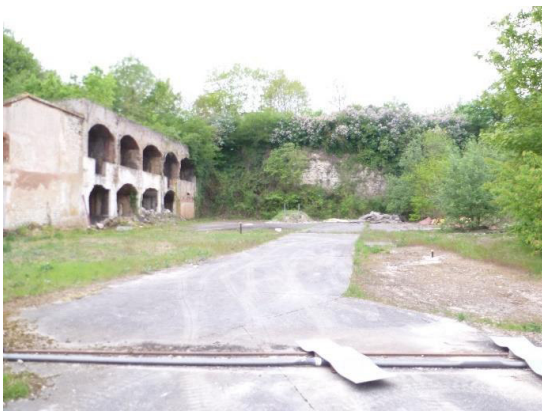
Vue sur le front de taille et sa végétation naturelle à conserver
