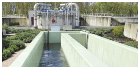
Station d'épuration d'Appoigny
