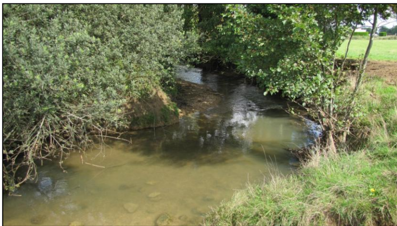
Photographie 18 : Ru de Baulche au droit d'une zone érodée
