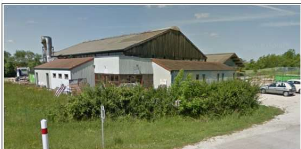
Menuiserie - entrée Nord
