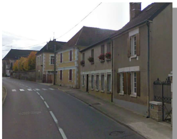
Route de St Florentin (RN 77)
