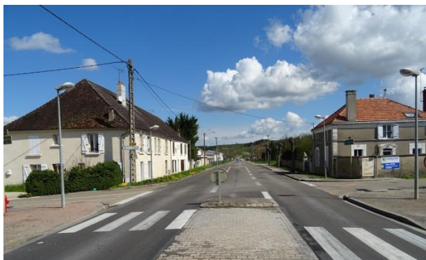
Bâti ancien à l'alignement de la RD 606.
