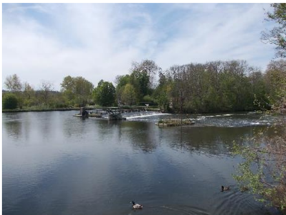
Photo 10 - Déversoir au niveau du hameau de Bailly
