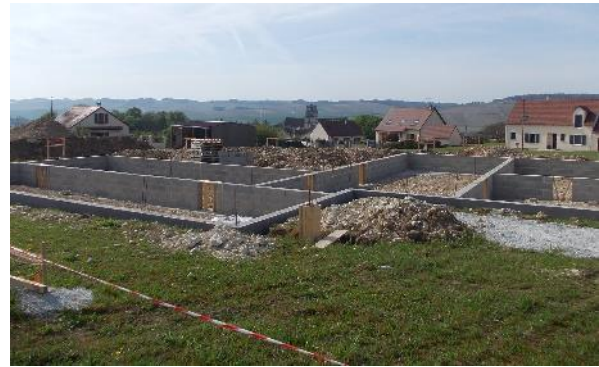
Photo 28 - Lotissement récent au Nord-Ouest du bourg
