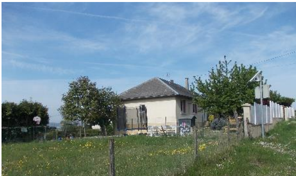
Photo 29 - Toiture à 4 pans des premières extensions
