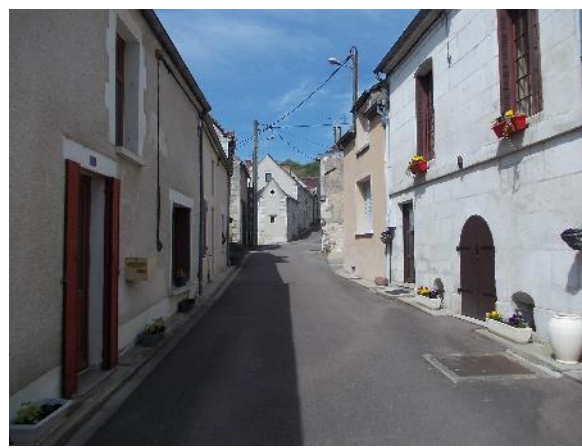
Photo 34 - Voie étroite et bâti à l'alignement
