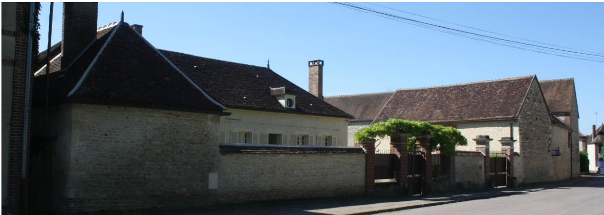
Ancien corps de ferme avec son logement principal et ses annexes
