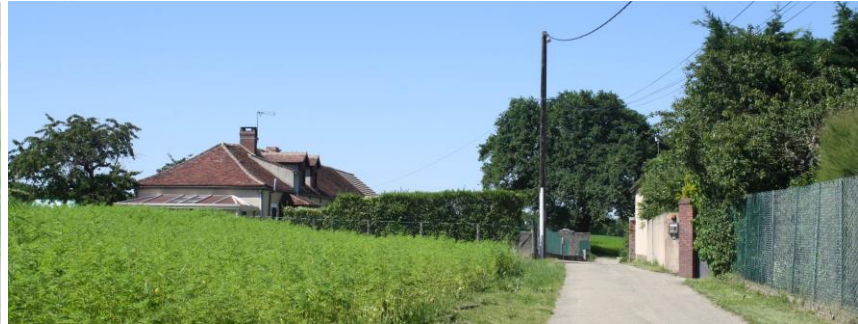
Vue depuis le chemin de la Source
