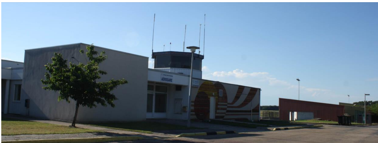
Bâtiments de l'aérogare et de hangar
