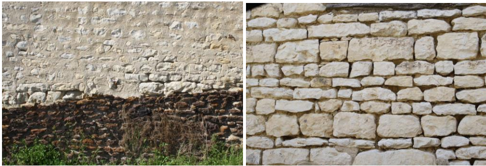
Appareillage en pierre calcaire et soubassement avec des fragments d'une roche plus dure
