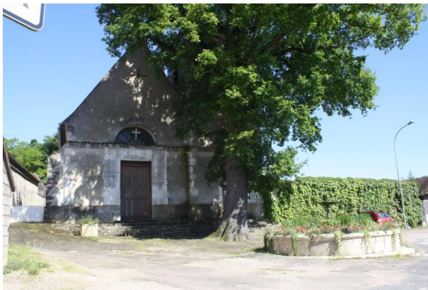
Parking à côté de l'église
