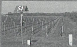
Différents types de bornes repérant les canalisations de transport
