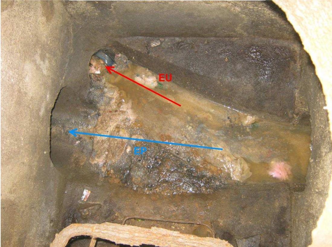
D'importants dépôts dans le déversoir d'orage peuvent altérer son bon fonctionnement. Lors de la visite de terrain, aucune surverse de temps sec n'a été constatée.
