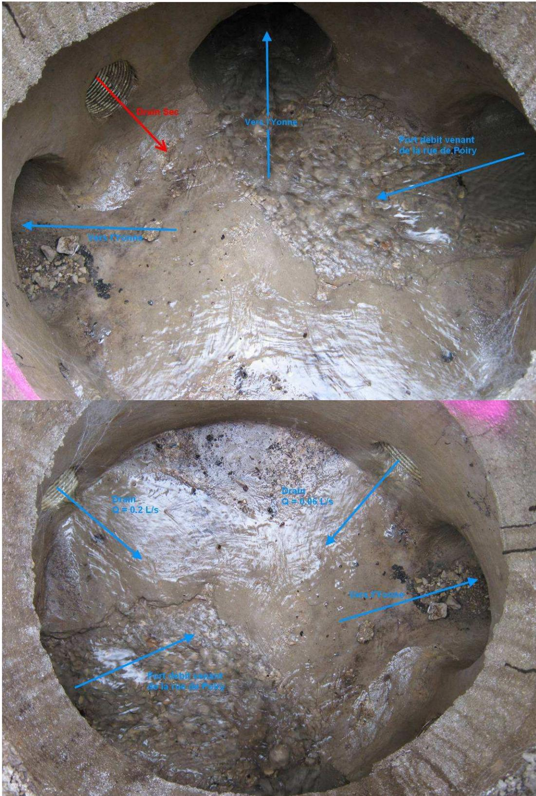
Ce déversoir d'orage s'apparente plus à un ouvrage de répartition d'eau pluviale.
