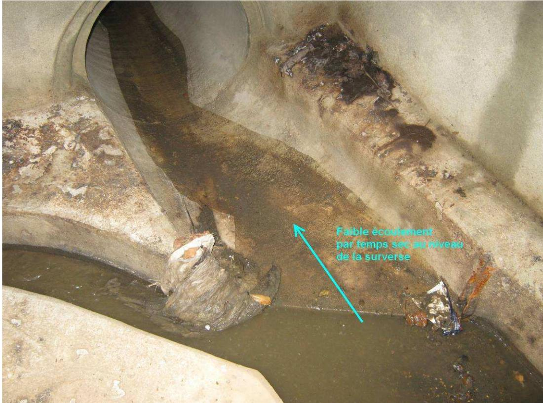
Le DO P1 présente un écoulement par temps sec au niveau de la surverse. La hauteur de la margelle pourrait être surélevée.
