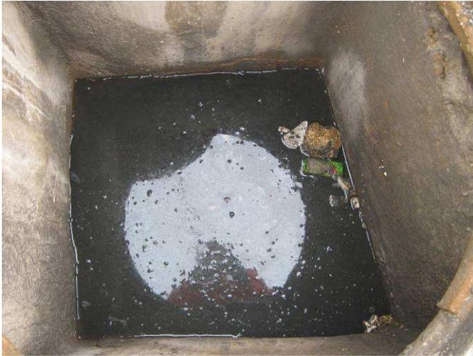
**Figure 6 : Regard EP\_5320 : regard noyé et présence d'embâcles dus à la remontée de l'Yonne**
