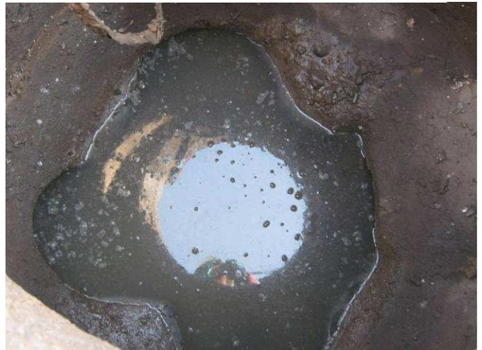
**Figure 3 : Regard EP\_3789 : regard noyé du à la remontée de l'Yonne**
