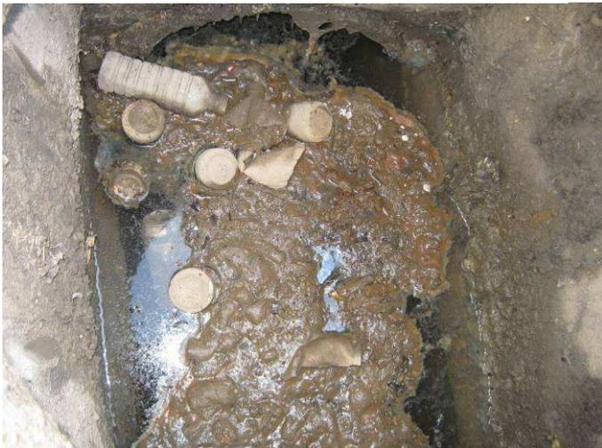
**Figure 2 : Regard EP\_3810 : eau stagnante et réseau en charge dus à la remontée de l'Yonne**
