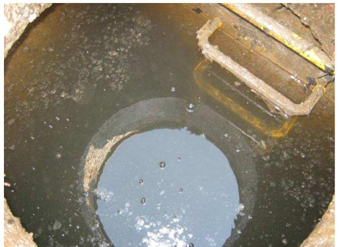
**Figure 5 : Regard EP\_5297 : regard noyé du à la remontée de l'Yonne dans le réseau**
