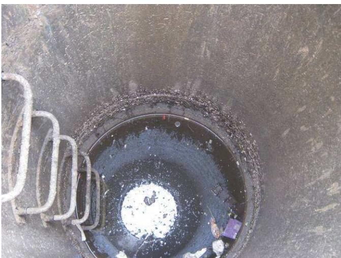
**Figure 4 : Regard EP\_3819 : regard noyé du à la remontée de l'Yonne dans le réseau**
