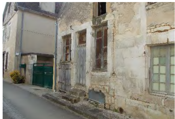
Photo 24 - Bâti vacant non entretenu
