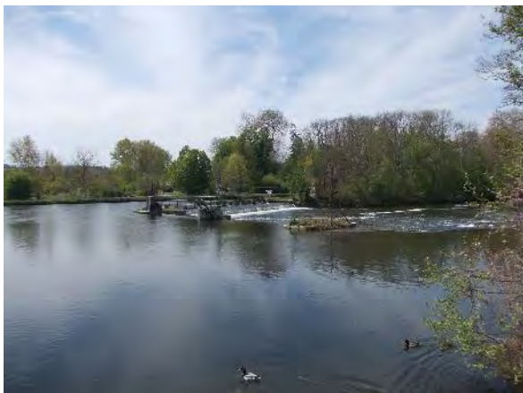
Photo 10 - Déversoir au niveau du hameau de Bailly
