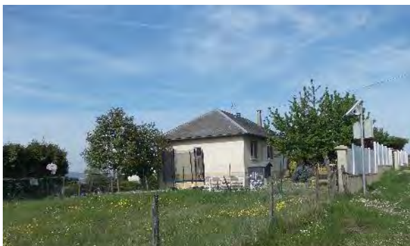
Photo 29 - Toiture à 4 pans des premières extensions
