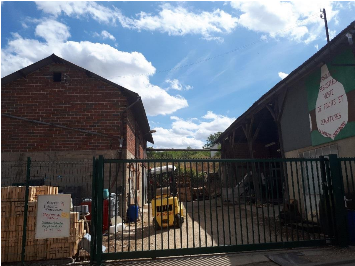
Figure 66 : photo de bâtiments agricoles en périphérie du bourg (source : CDHU)
