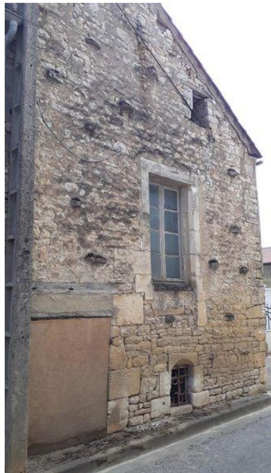
Figure 30 : exemples de bâti délabré – photographies 4 et 5 sur carte (photographies CDHU)
