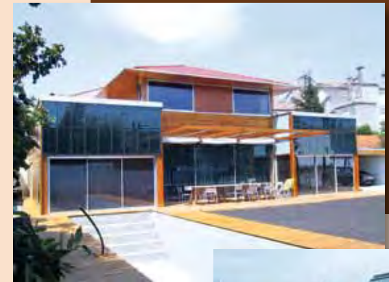
> Capteurs thermiques en façade (Chauffage)
