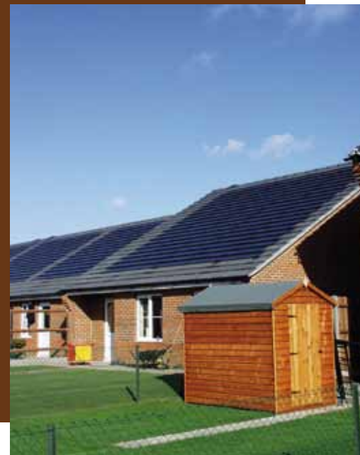
> Intégration photovoltaïque en toiture
