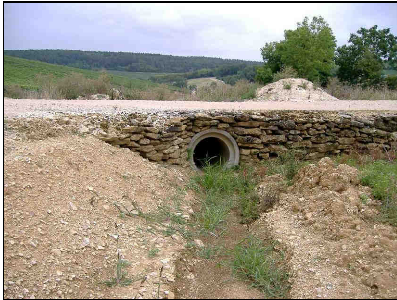
Photo 3 : exutoire de type fossé busé, à Beine
