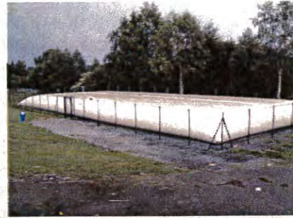
Citerne souple avec poteau d'aspiration
