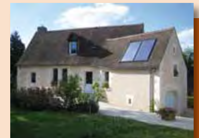
> Capteurs intégrés en toiture (CESI)
