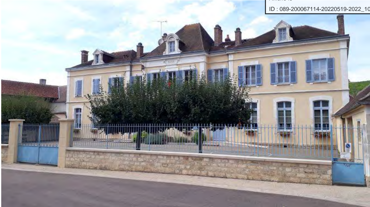
Figure 49 : mairie et école primaire de Chitry-le-Fort (photographie CDHU)
