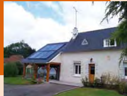
> Capteurs thermiques intégrés en toiture secondaire (Chauffage)
