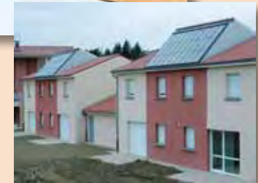
> Couverture totale en capteurs solaires thermiques (Chauffage)
