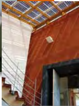
> Capteurs photovoltaïques semi-transparents en verrière
