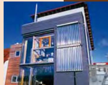
> Capteurs sous vide en façade
