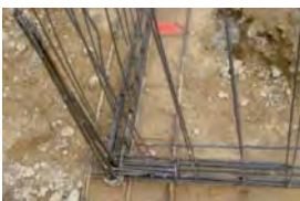
Nœud de chaînage - Continuité mécanique
