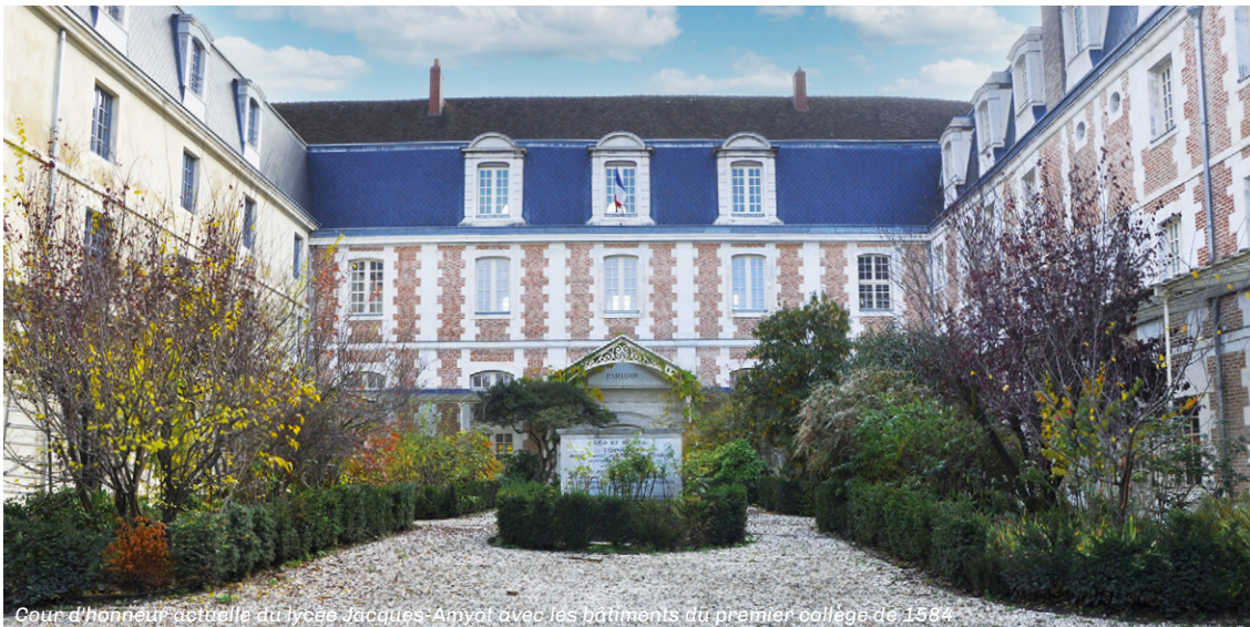
Cour d'honneur actuelle du lycée Jacques-Amyot avec les bâtiments du premier collège de 1584.
