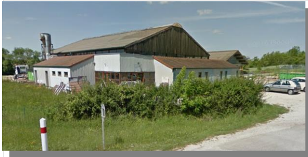
Menuiserie - entrée Menuiserie - entrée
