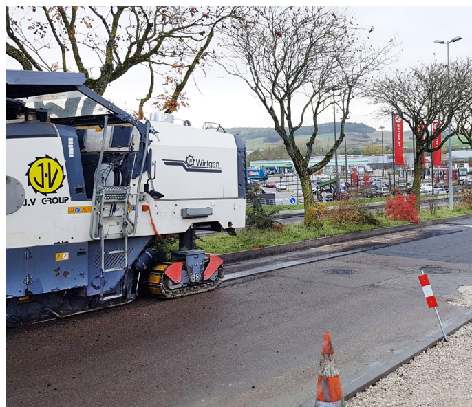
Création de voirie - ZAE AuxR_Parc - Appoigny
