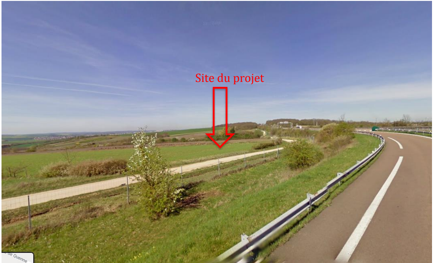
Vue du terrain depuis la sortie de l'Autoroute
