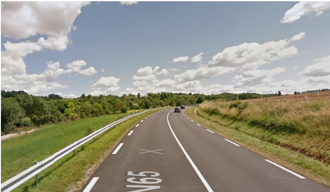
Point de vue n°1 sur la RN 65
