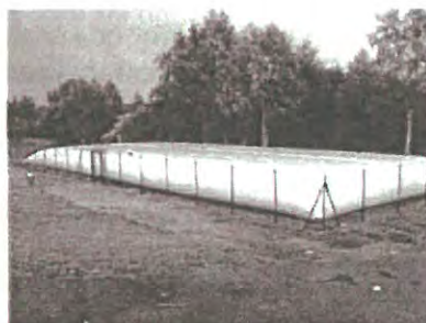
Citerne souple avec poteau d'aspiration
