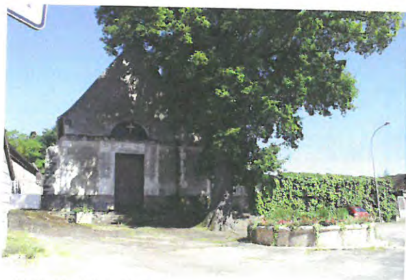
Parking à côté de l'église
