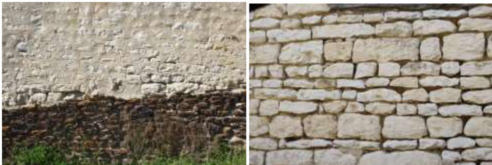
Appareillage en pierre calcaire et soubassement avec des fragments d'une roche plus dure
